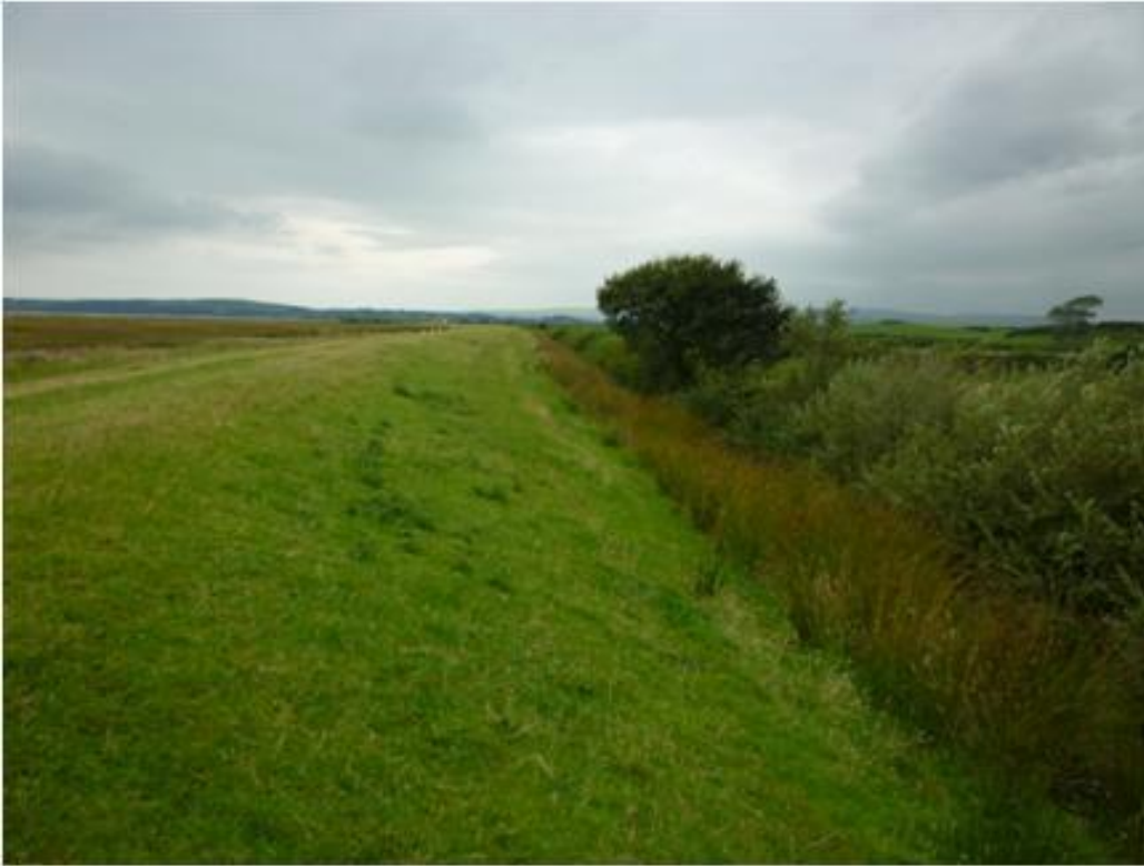
H1: Levee ditch
